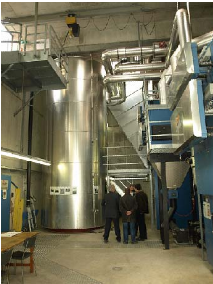
Centrale di Sumiswald, accumulatori e filtro elettrostatico (altezza 8 m)
