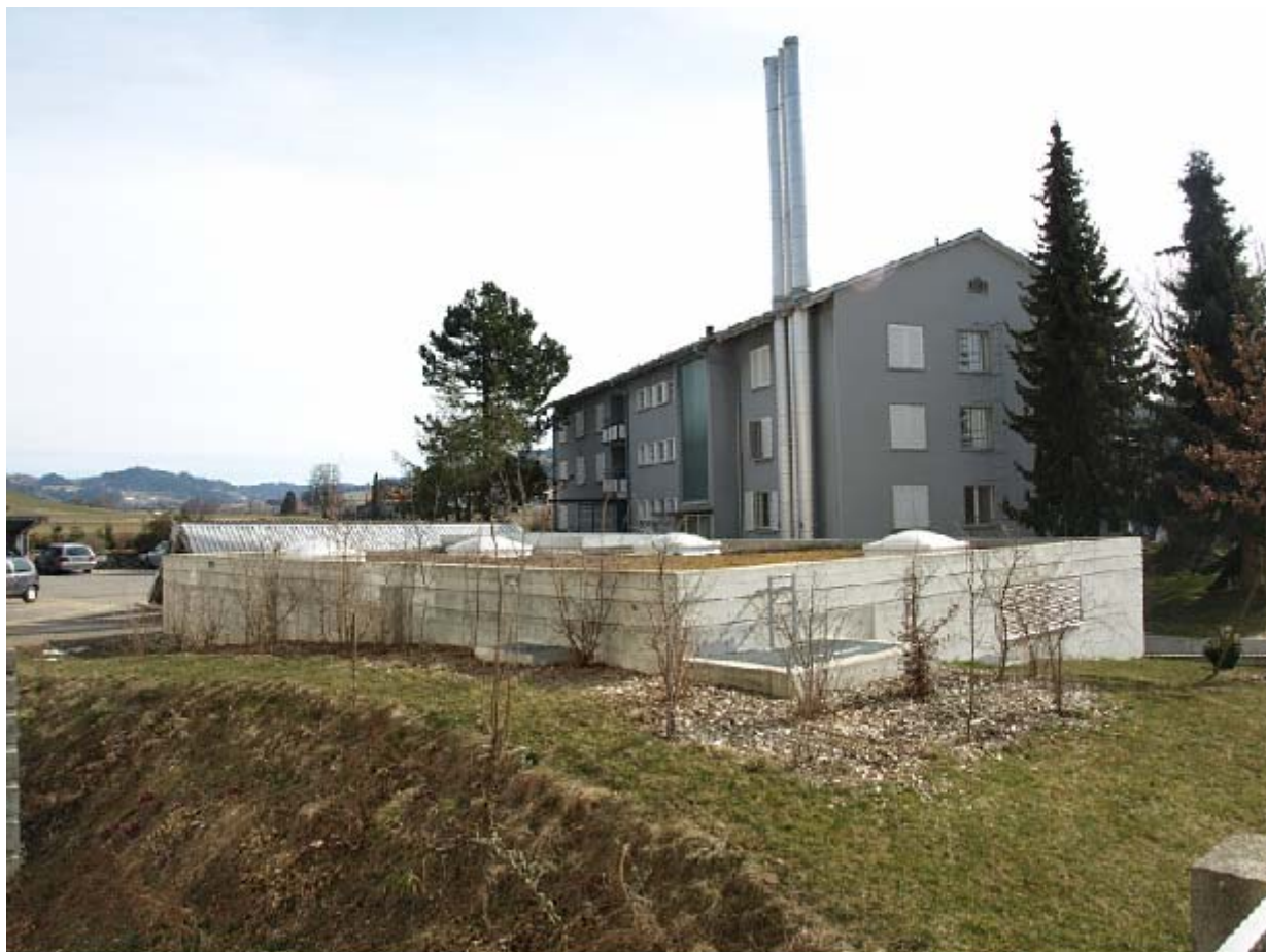
Centrale di Sumiswald, parzialmente interrata
