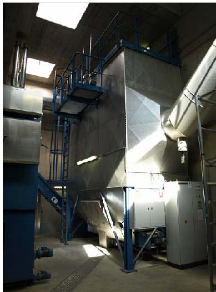
Centrale di Sumiswald, accumulatori e filtro elettrostatico (altezza 8 m)
