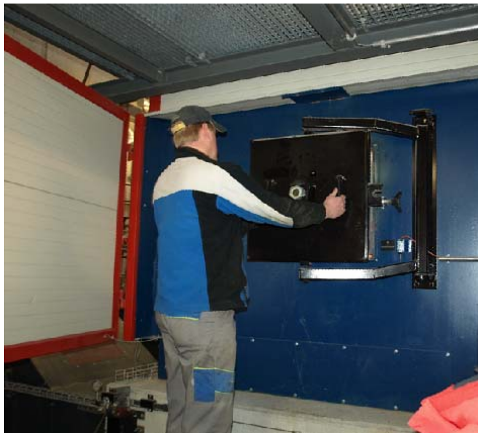
Centrale di Schattdorf, bruciatore 3 MW
