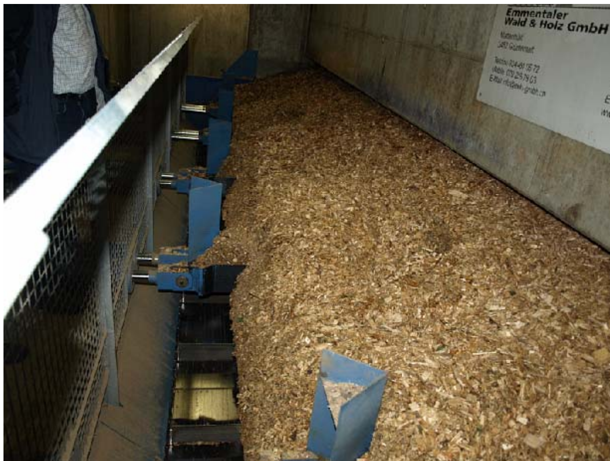
Centrale di Saffenwil, sistema di trasporto del cippato
